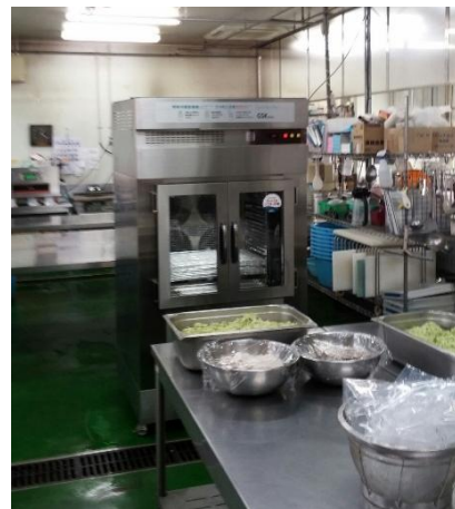
山路フードセントラル加工場に 設置のKF-2000 ここで加工して全店に配送
